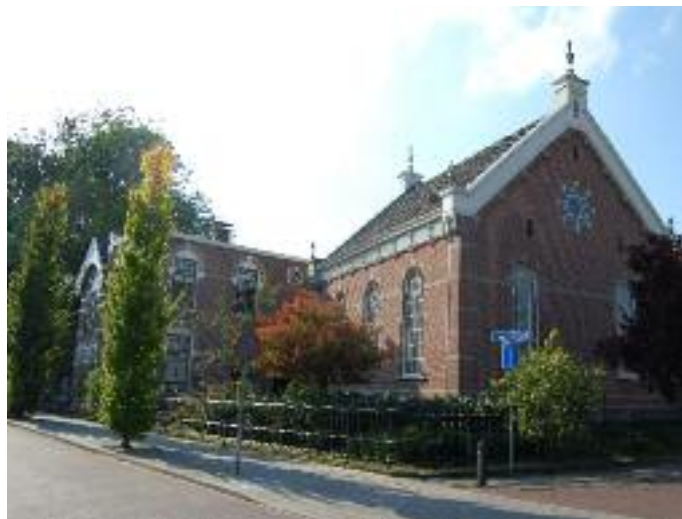
Het synagogecomplex aan de Spoorstraat is erkend als rijksmonument.
